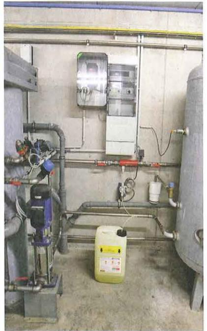
Eine Chlordioxidanlage bereitet das Wasser auf, bevor es in die Wasserleitung kommt.
